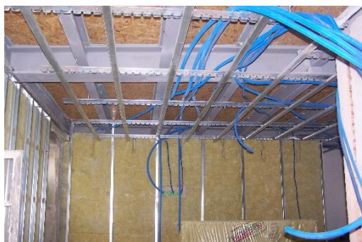
Fig. 140 – Estrutura para revestimento gesso cartonado
