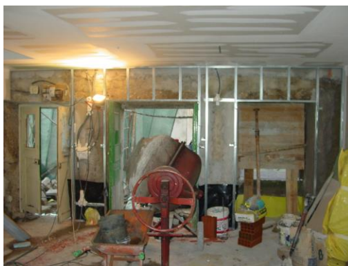
Fig. 306 – Revestimento de paredes
