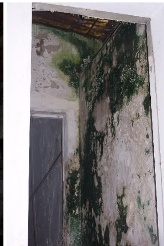
Fig. 127 – Degradação do reboco
