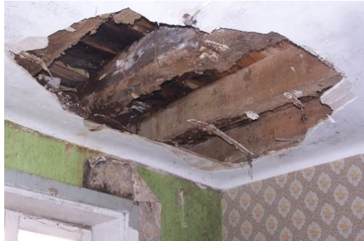
Fig. 123 – Degradação do teto e estrutura entre pisos
