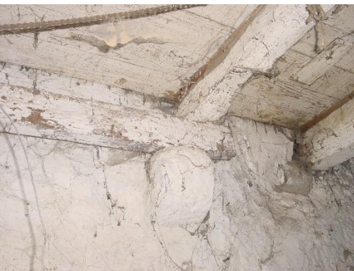
Fig. 162 – Vigamento em madeira de suporte do 1º piso
