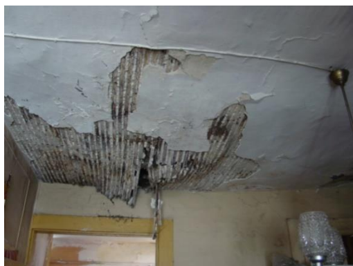
Fig. 323 – Degradação do teto
