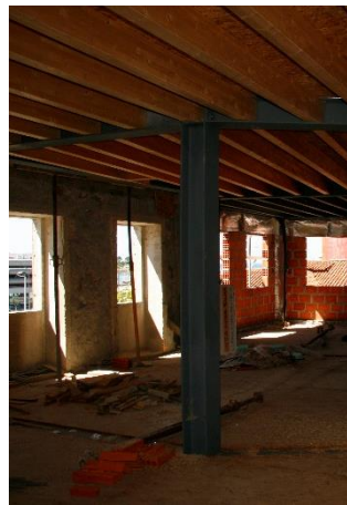
Fig. 237 – Estrutura de pisos
