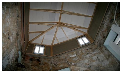
Fig. 267 – Estrutura de cobertura do recuado
