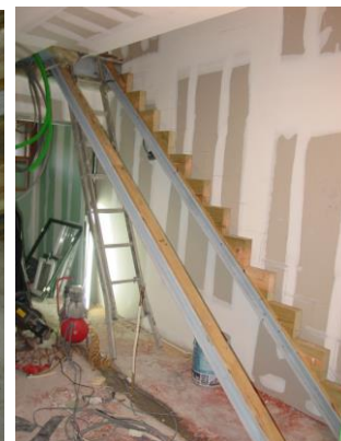
Fig. 304 – Estrutura para as escadas
