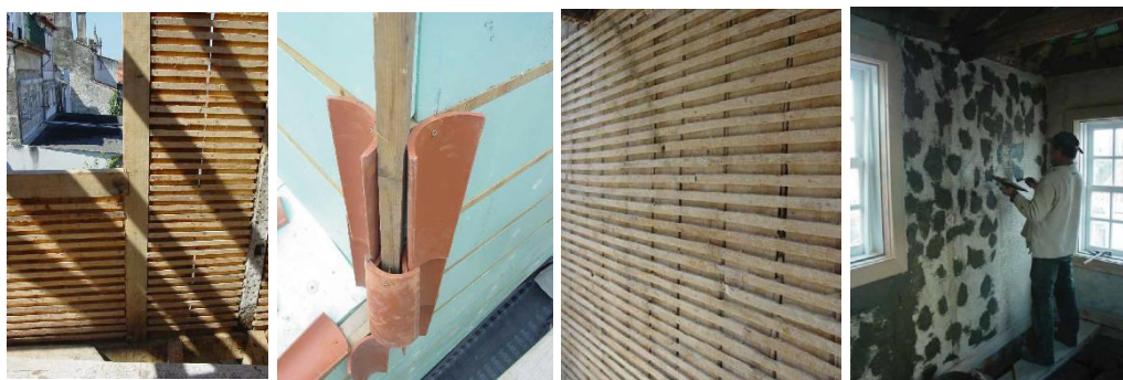
Fig. 339 – Taipa de fasquio Fig. 340 – Telha aparafusada Fig. 341 – Taipa de fasquio Fig. 342 – Revestimento
