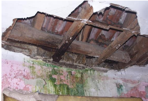
Fig. 124 – Degradação do teto e estrutura de
