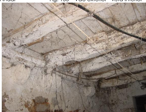
Fig. 157 – Vigamento em madeira de suporte do 1º piso
