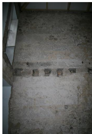
Fig. 271 – Parede autoportante
