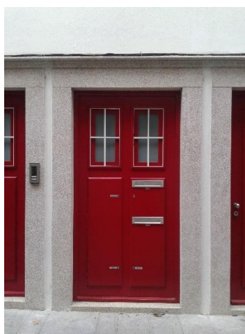
Fig. 363 - Porta inviabilizada que oculta a caixa de visita do gás, as caixas de correio e os contadores
