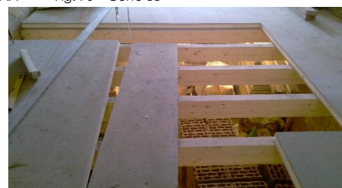
Fig. 72 – Estrutura de piso e pavimento em soalho
