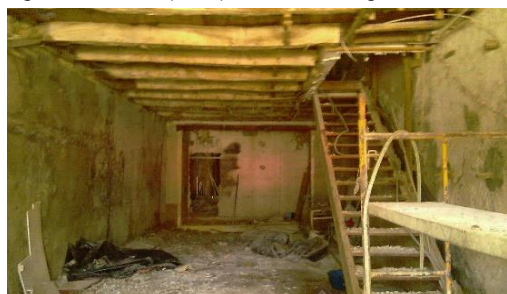
Fig. 52 - Vigamento e estrutura de pisos
