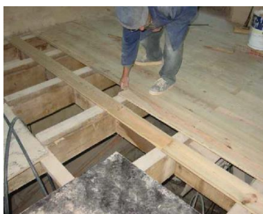
Fig. 336 – Estrutura pisos e pavimento
