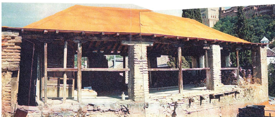
Fig.71: Aspecto de la torre-secadero en el momento de la rehabilitación. Obsérvese la estructura de pilares de ladrillo y pies derechos de madera.
