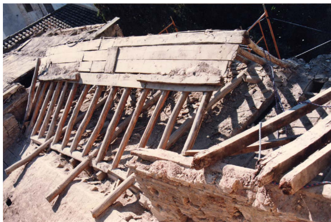
Fig.109: Desmontaje de la cubierta de la crujía sur durante la rehabilitación.
