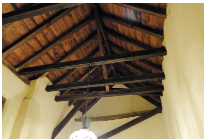
Fig.110: Armadura simple de par e hilera de ejecución más moderna. Caja de escalera actual.
