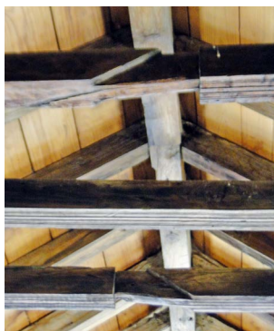
Fig.72: Detalle de la armadura. Obsérvese los cortes que presentan algunos nudillos, antiguos pares. J. Lara García, 2017.
