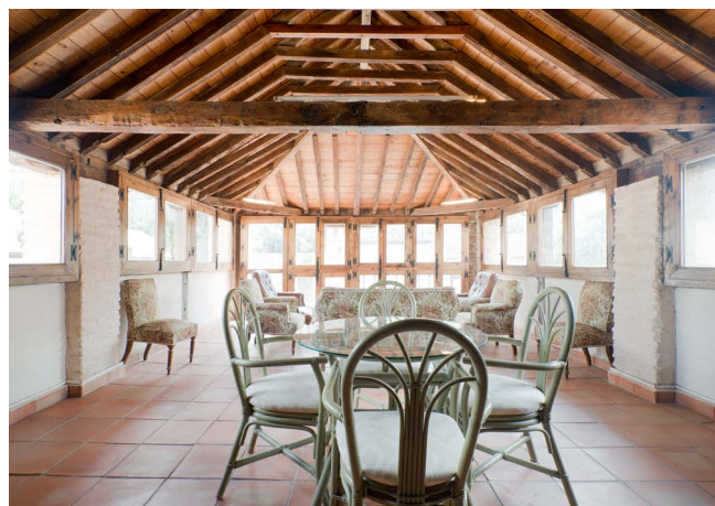
Fig.72: Detalle de la armadura. Obsérvese los cortes que presentan algunos nudillos, antiguos pares. J. Lara García, 2017.
