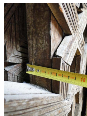
Fig.105: Detalle de la armadura apeinazada. Obsérvese que justo en este punto la labor de lacería (taujes) está superpuesta a la parte estructural.
