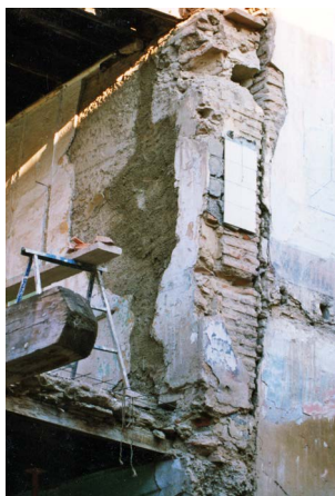
Fig.81: Aspecto del muro medianera norte en su contacto con la crujía de fachada durante la rehabilitación. Obsérvese la envergadura del muro y su independencia estructural.
