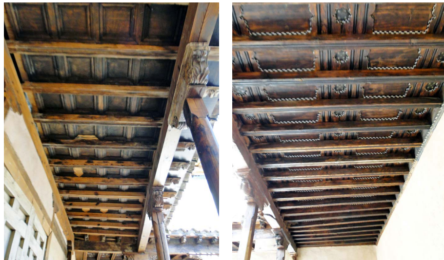
Fig.98a: Alfarje de cinta y saetino con moldura renacentista. Galería sur, planta alta.
