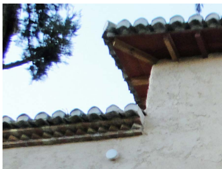
Fig.91a: Detalle del alero con canecillos agramilados y remate de tracería gótica de tres lóbulos. Galería oeste, planta alta.
