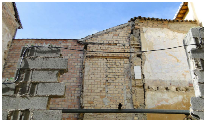
Fig.58: Muro moderno de cierre con el patio (izq.) y muro antiguo divisorio con la crujía segregada y correspondiente con el espacio de debajo de la armadura (dcha.). Obsérvese la discontinuidad del nivel del entresuelo y el perfil de la galería norte.
