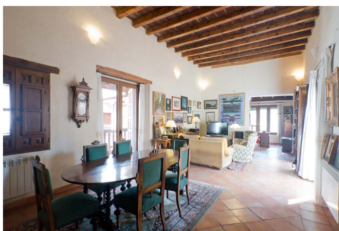
Fig.70: Vista del salón principal en planta primera de la crujía oeste. Presenta un alfarje más moderno que el resto, posiblemente en sustitución de la armadura que lo cubría antes de la construcción de la torre-secadero sobre él.
