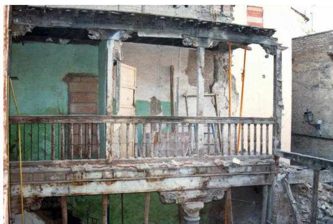
Fig.66: Aspecto de la galería norte durante la rehabilitación. Obsérvese el acceso cegado a la crujía segregada.
