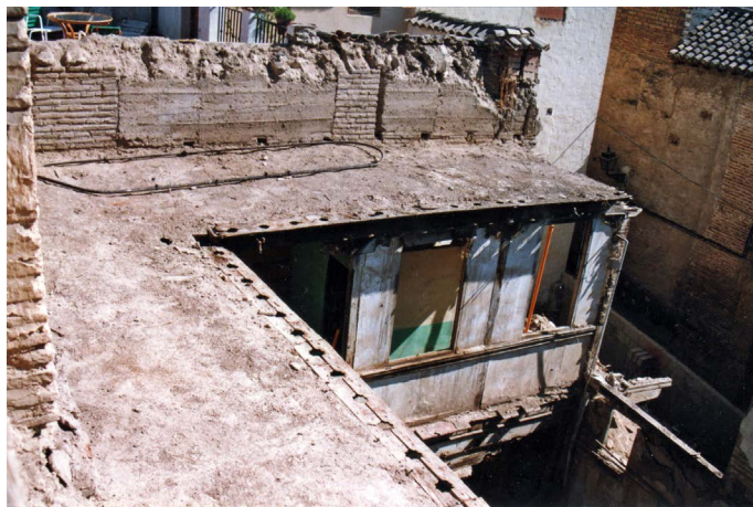
Fig.82: Aspecto del muro medianera y galería norte durante la rehabilitación. Obsérvese la buena conservación de la tapia de verdugadas y machones de ladrillo con cajones de tierra con cal, conservada bajo los faldones de la cubierta de las galerías.
